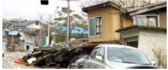
写真16 家屋被災状況（竜光地区）
