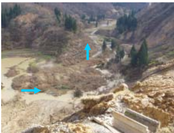
写真8 河道閉塞箇所（南平，閉塞河道）
