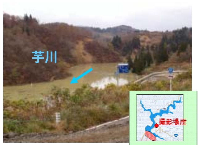
写真11 震生湖上流方向（平成16年11月13日）
