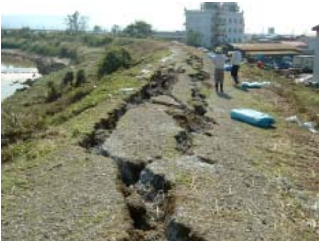
写真2 刈谷田川五百刈地先の堤防被害 【GPS】: N 37° 31' 35" E 138° 52' 43" 2004.10.28
