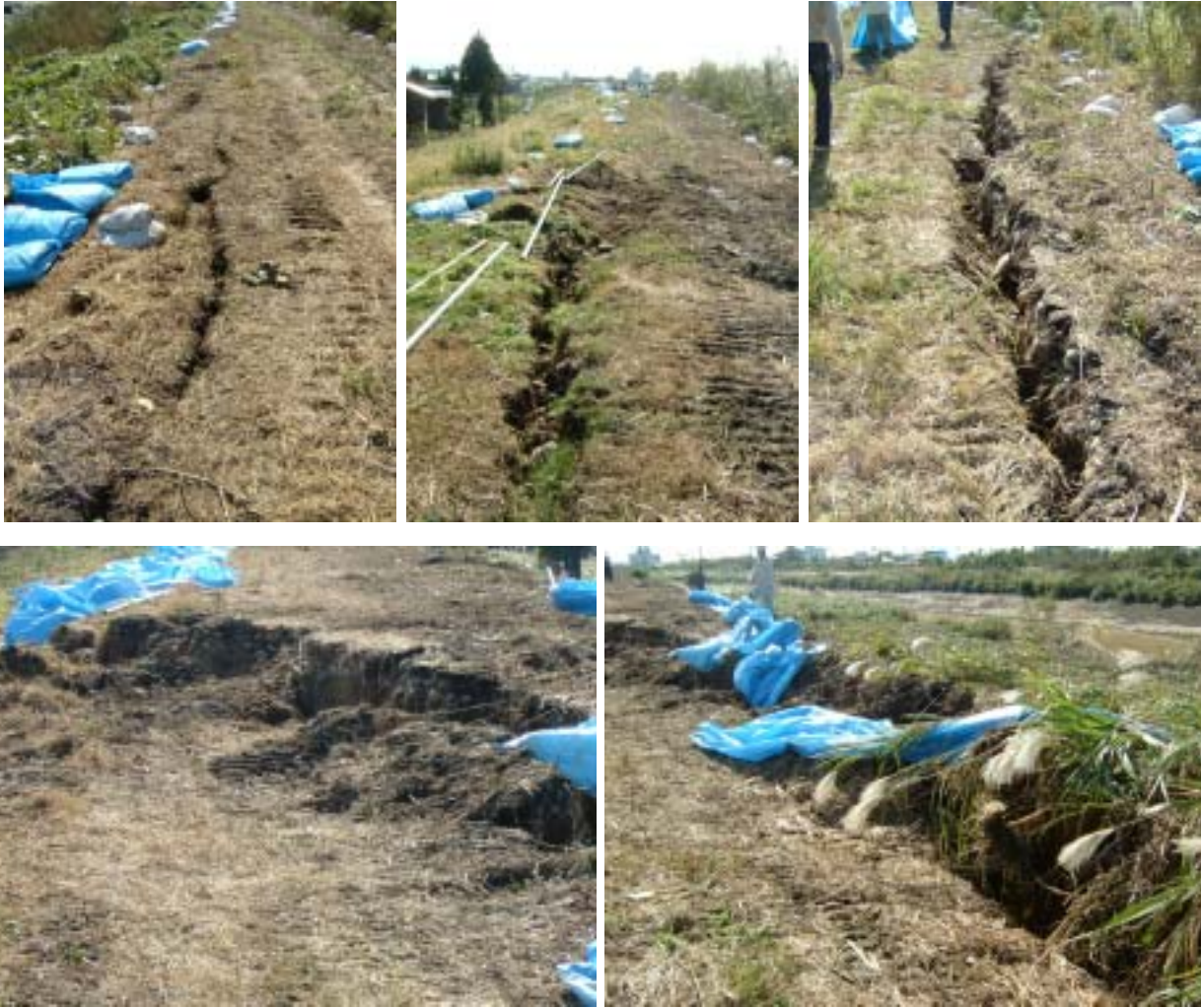
写真4 刈谷田川山吉町地先の右岸堤防
