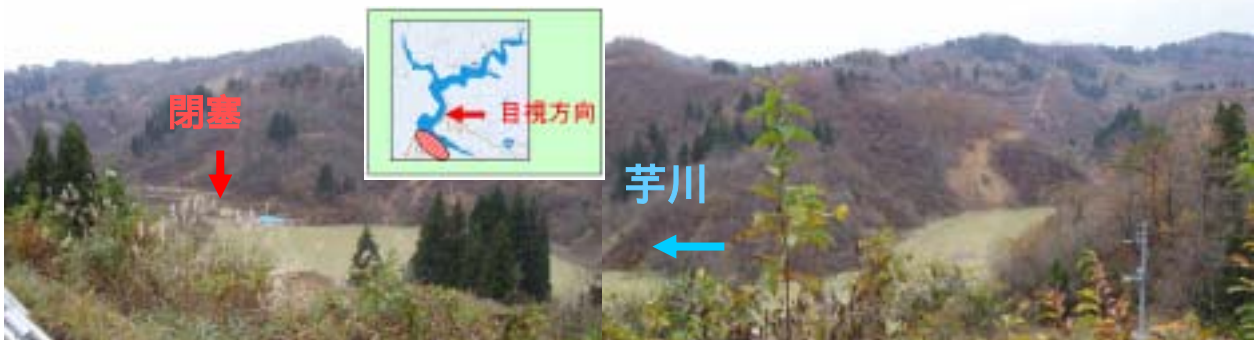
写真13 芋川側震生湖遠景（平成16年11月13日）
