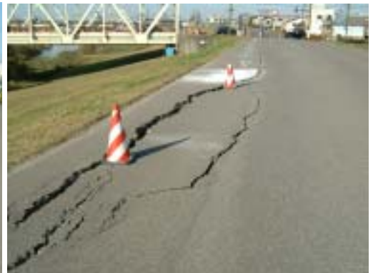
写真6 信濃川長生橋付近の堤防天端上のアスファルトの亀裂
