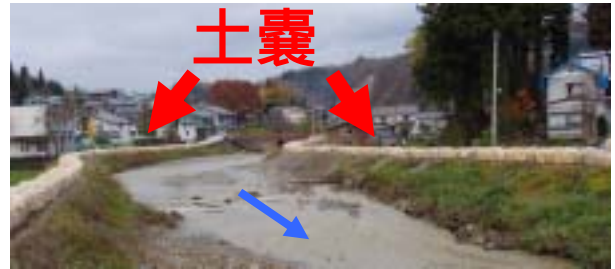
写真17 土嚢設置状況（竜光地区）
