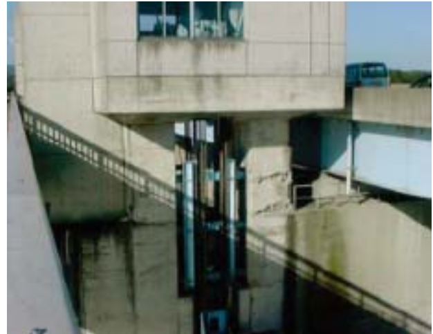
写真7 妙見堰 No.1 ゲートの被災 1) より抜粋 コンクリートの剥落と鉄筋の露出
