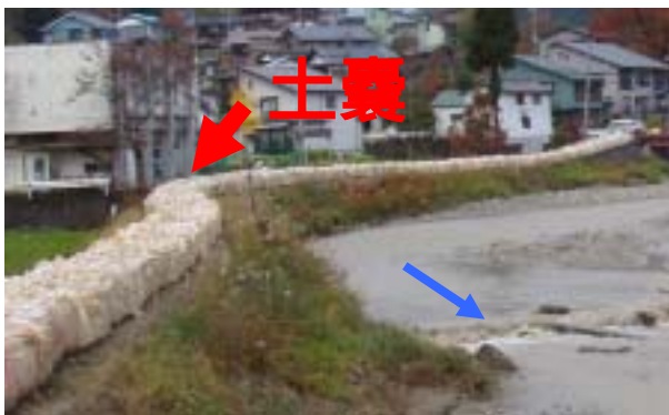
写真15 土嚢設置状況（右岸拡大）
