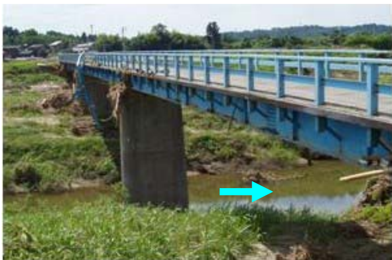
桜明橋 (平成16年7月22日)
