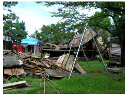
写真4 倒壊した神社 (西本町2丁目)
