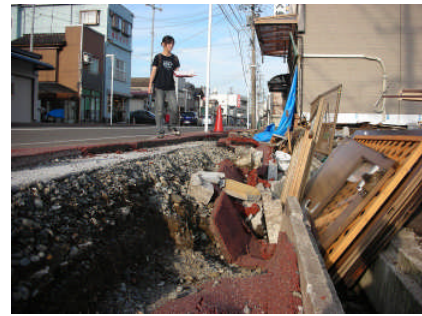
写真3 地盤沈下による宅地被害 (西本町2丁目)
