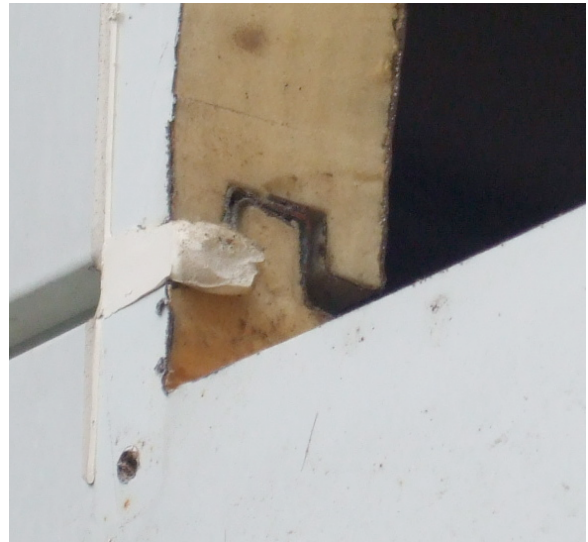
写真 17. D 社のパネルの構造（中越沖地震、長岡市陽光台仮設住宅）
