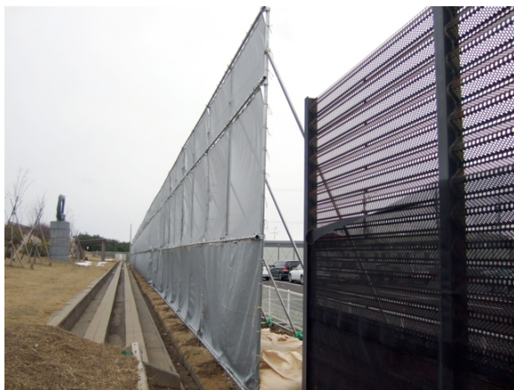
写真 12. 海岸部の仮設住宅の防風ネット（柏崎市）
