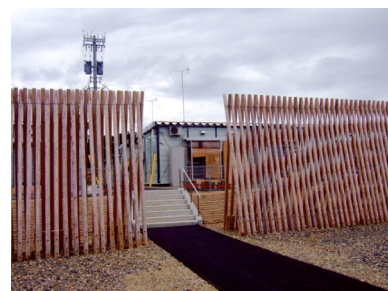
写真 8. 防風壁（輪島市門前町道下仮設住宅）
