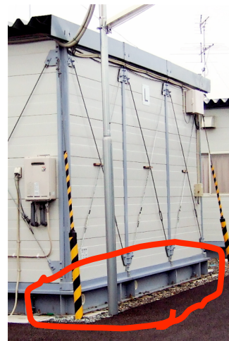
写真 13. 海岸部の仮設住宅。基礎が鉄骨で、そこに建物が緊結されている（柏崎市）
