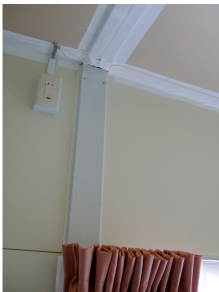
写真9. 柱のプラスチックカバー
