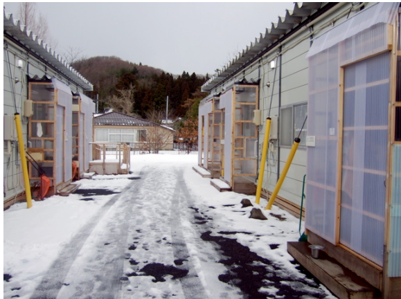
写真 11. NGO の寄付により取り付けられた風除室。引き戸タイプは一部自己負担有りと聞いている
