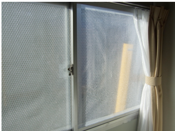
写真 19. 筆者が行なったプチプチシートの施工例 (柏崎市西山町別山仮設住宅)
