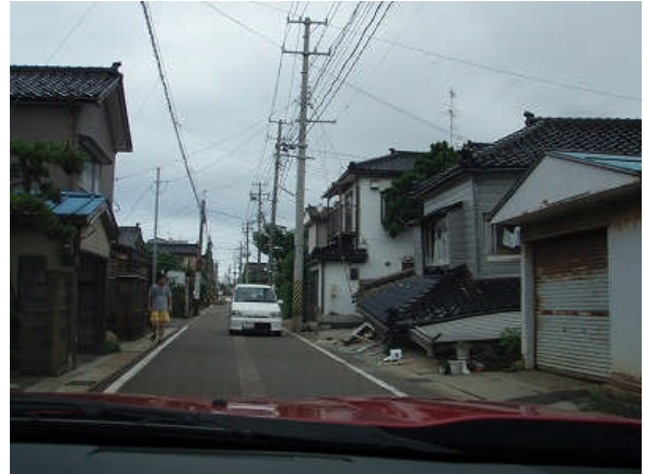
図 4.倒壊した家屋（一階部分がつぶれている）
