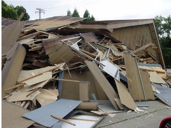
図 2.倒壊した木造家屋
