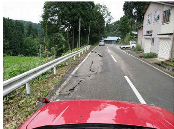
図1.峠での車道の亀裂(陥没)
