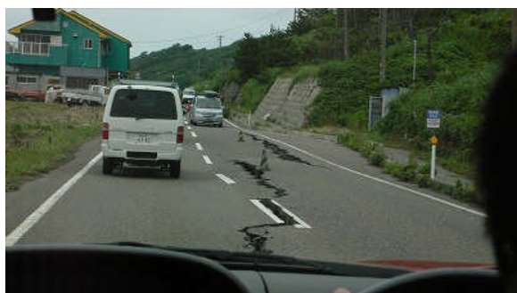
図 21.海岸線沿いの割れた道路
