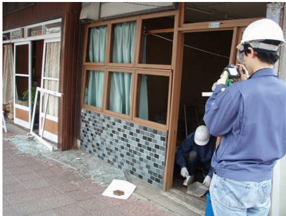
図 12.全てガラスが割れた窓
