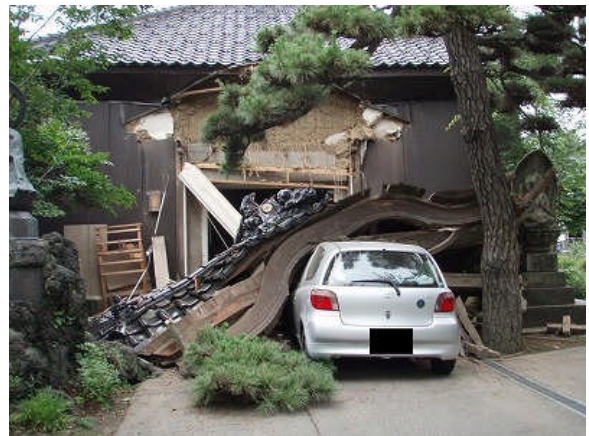
図 14 倒壊した閻魔堂の軒先
