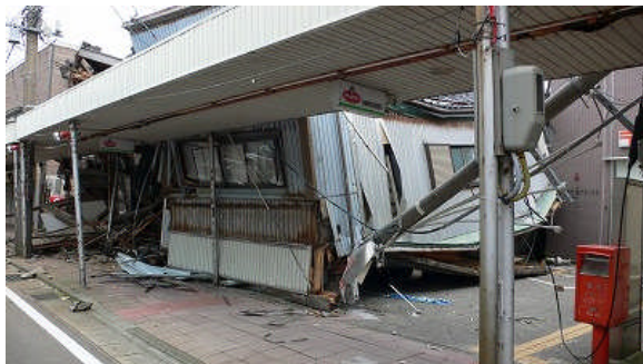
図 17.倒壊し、二階部分がアーケードに 支えられている
