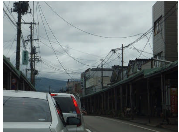
図 5.電線が大きくたわんでいる
