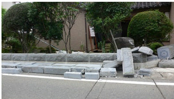
図 3.倒壊したブロック塀
