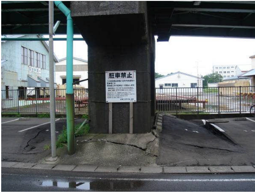
跨線橋の橋脚周辺地盤の変状 下村団員
