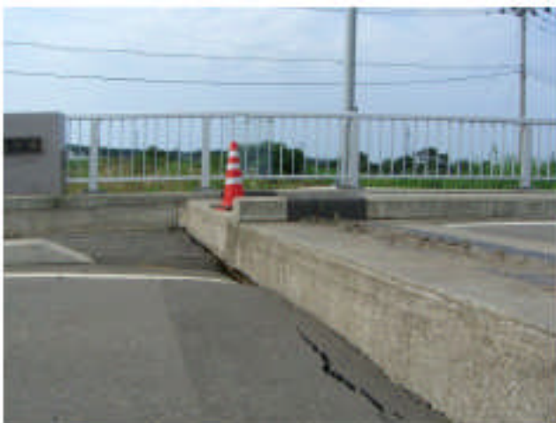
(g) 橋台背面の沈下(元治橋)
