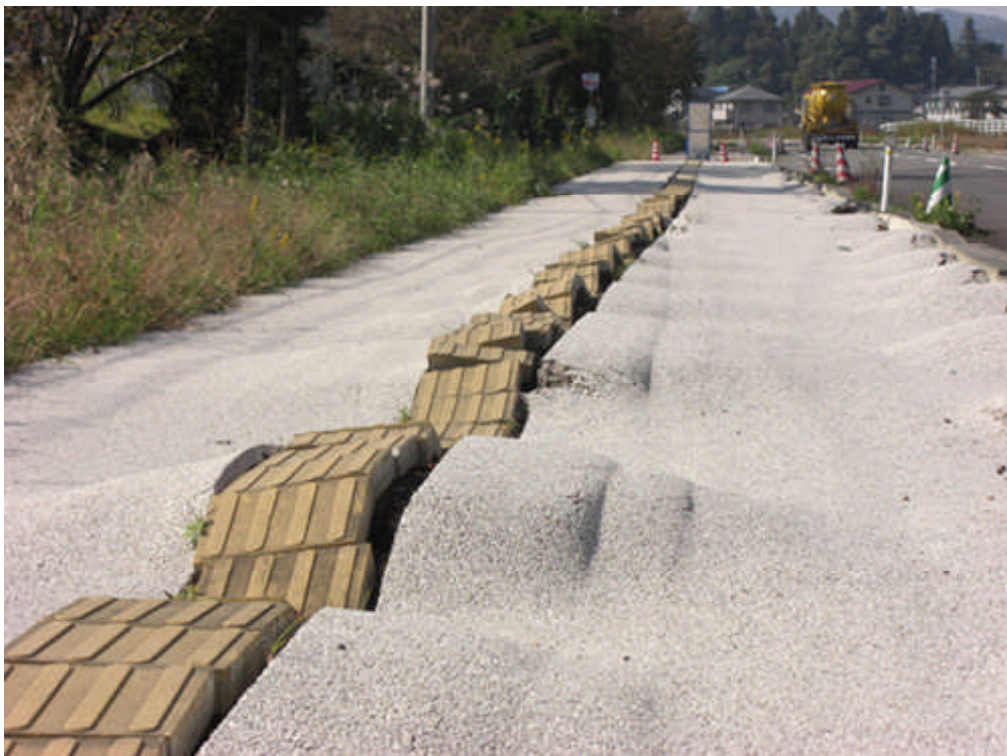
柏崎市堀町周辺の歩道、マンホール、雨水施設 山口団員
