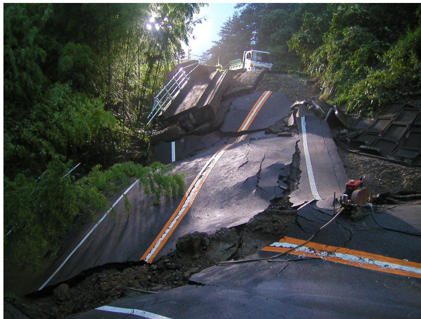
長岡市大積付近で発生した土砂崩れによる路盤崩壊（国道8号線）
