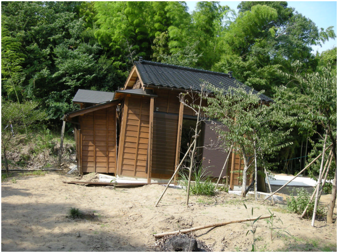
刈羽村稲場地区において液状化に伴い被災した家屋
