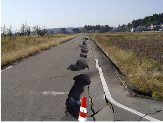
図4 マンホールの浮き上がりおよび埋設管理戻材液状化による陥没箇所 (長岡市提供)
