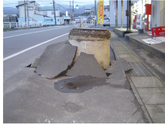
図4 マンホールの浮き上がりおよび埋設管理戻材液状化による陥没箇所 (長岡市提供)
