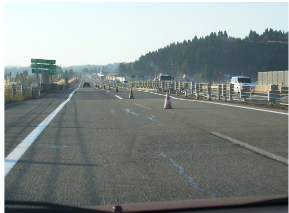
図 1 11 月 5 日、片側 1 車線で一般開放された関越自動車道
