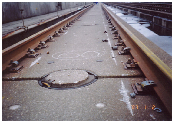
写真 17 車輪の擦過痕
