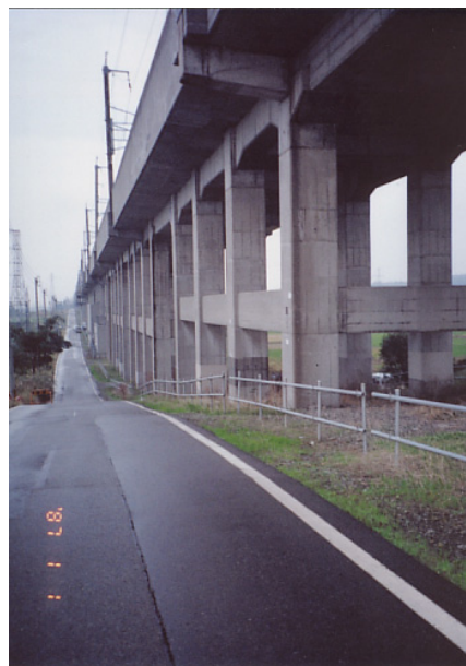
写真 19 脱線が始まったとされる地点から 長岡駅方的高架橋
