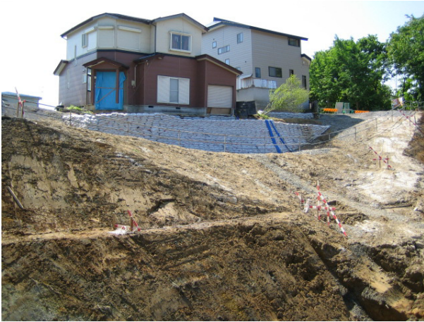
写真 46 本復旧による盛土の施工状況
