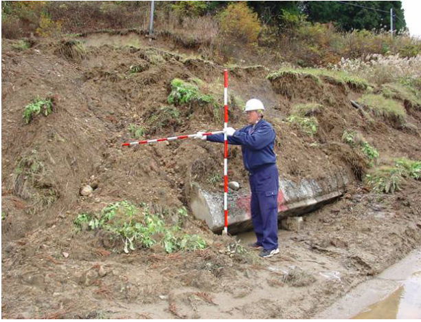
写真 32 もたれ式よう壁の崩壊事例
