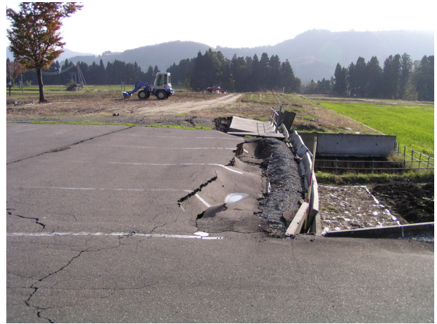
写真 11 盛土の主働せん断破壊
