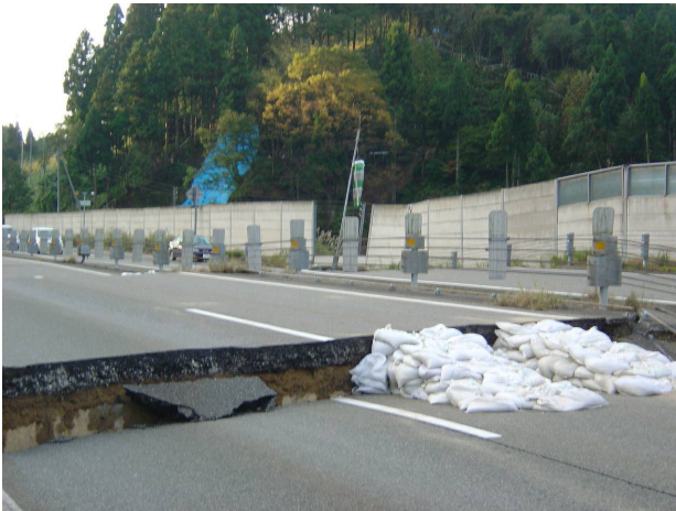
写真1 盛土変形による段差（関越自動車道） 2)
