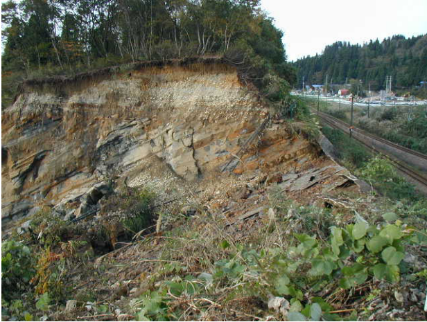
写真 36 切土と反対方向への岩盤層すべり(川口町大道平)
