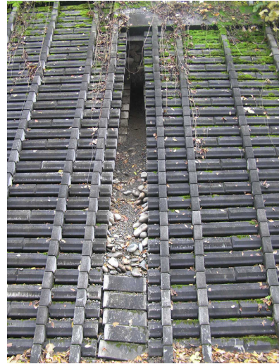
写真 27 井桁対策工の損傷事例
