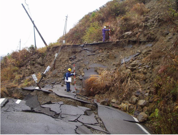
写真 25 地すべりによる切土斜面の被害
