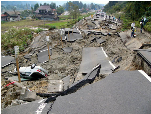
写真 18 国道 117 号線塩殿の盛土崩壊
