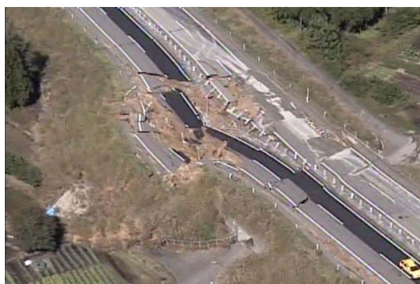
写真 21 関越自動車道の盛土崩壊 2) (堀之内町)
