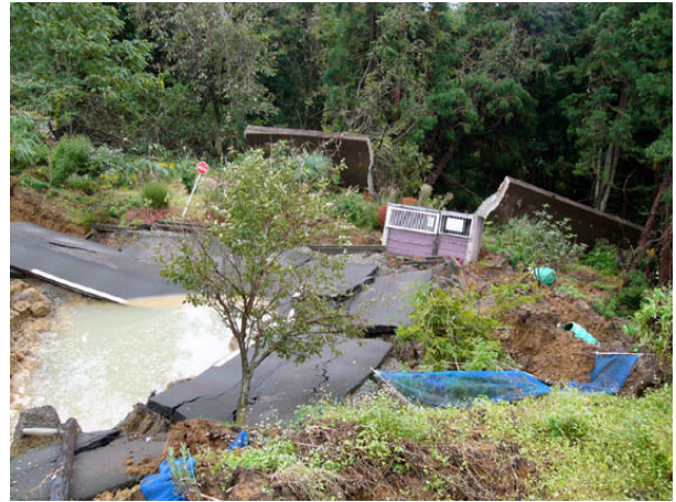
写真 43 盛土崩壊に伴う重力式よう壁の変位 6)
