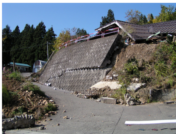
写真 31 ブロック積よう壁の崩壊事例 (旧山古志村)
