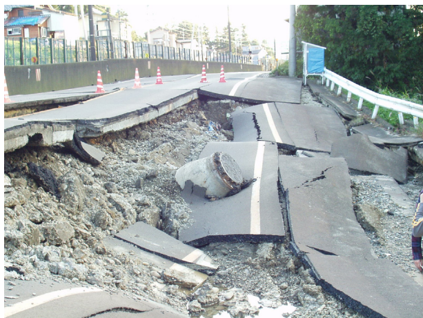
写真 16 沢筋における道路盛土の崩壊
