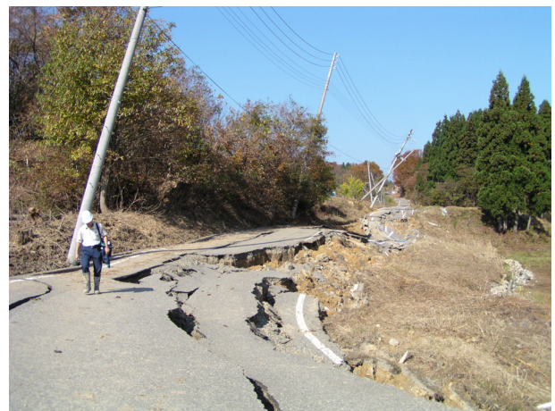
写真15 緩傾斜地盤上の盛土崩壊 (旧山古志村)
