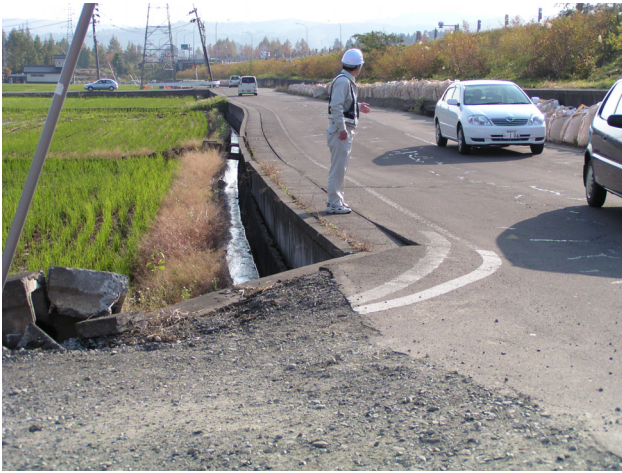
写真 9 盛土の変形に伴う周辺地盤の損傷
