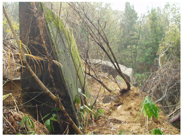
写真 44 被災した重力式よう壁の状況
