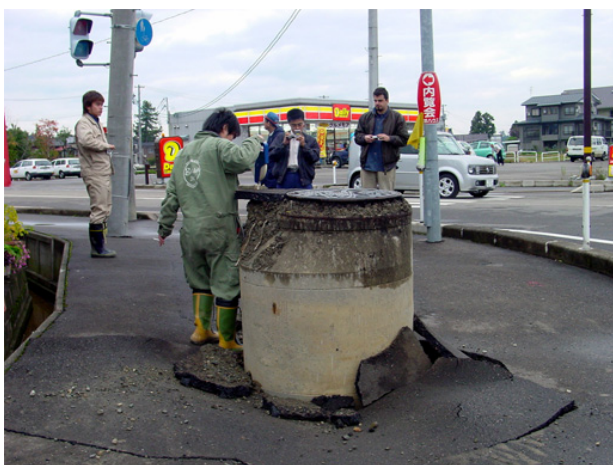
写真5 液状化によるマンホールの浮き上がり 3)
