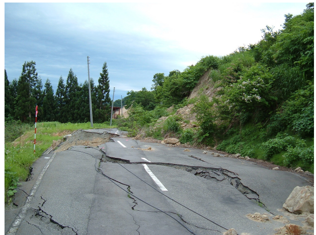
写真 23 切土斜面における落石・表土の崩壊
