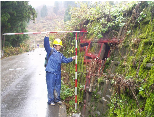
写真 33 ブロック積よう壁の孕み出し（長岡市濁沢）
