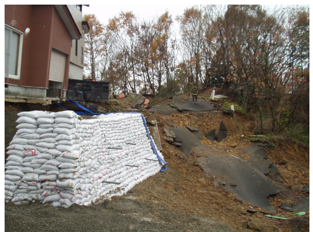
写真 45 仮復旧による土嚢の設置
