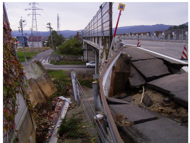
写真3 盛土変形による段差（関越自動車道） 2)
