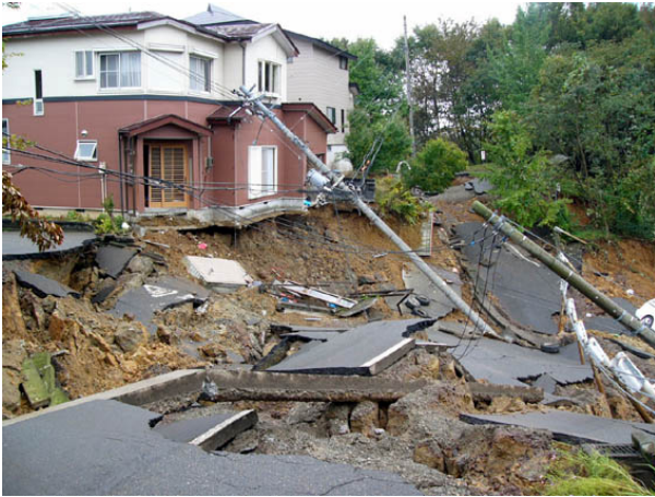
写真 41 高町団地における大規模盛土崩壊
