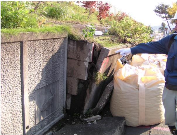
写真 10 盛土のはらみ出しによるパネル崩壊
