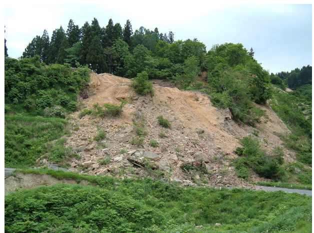
写真 24 切土斜面の崩壊による雪崩防止柵の破壊
