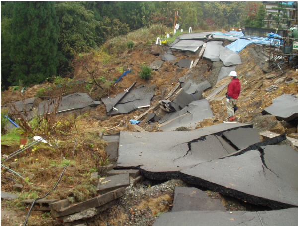
写真 42 盛土の崩壊による周回道路の消失
