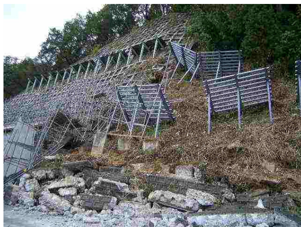
写真 30 国道 17 号線牛ヶ島の切土崩壊事例
