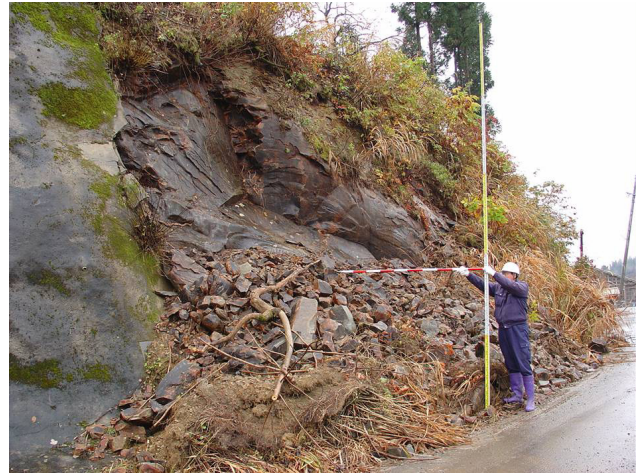
写真 34 モルタル吹付け工の崩落防止効果
