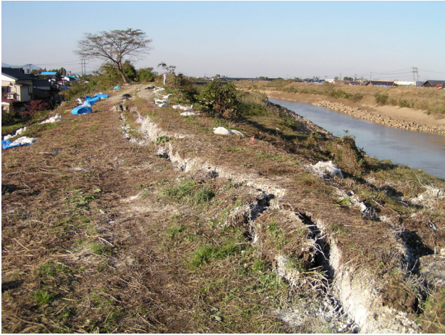
写真13 堤防の横断方向へのすべり破壊 (刈谷田川)
