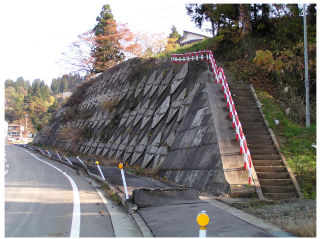
写真 35 アンカー工による斜面对策
