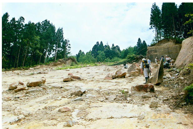
写真 29 岩盤層すべりのすべり面状況
