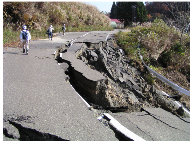
写真14 急傾斜地盤上の盛土崩壊 (旧山古志村)
