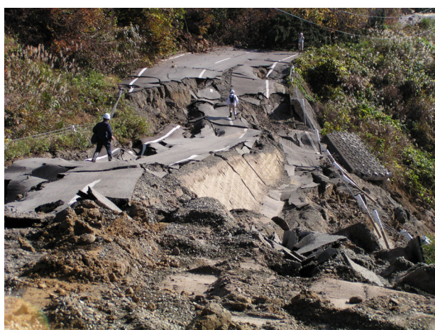
写真 17 谷埋め道路盛土の崩壊（旧山古志村）
