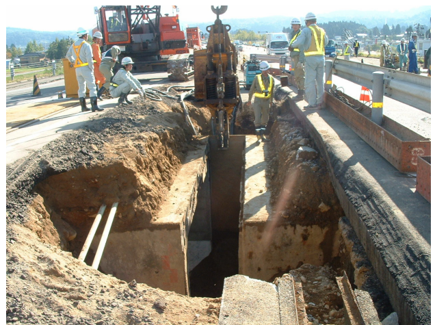
写真7 盛土の側方変形によるボックス・カルバートの開口 2) (関越自動車道)
