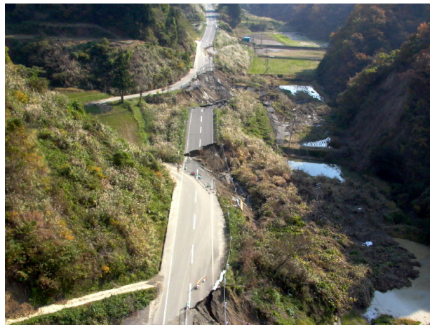
写真 20 付替え道路の崩壊 5) (旧小国町)
