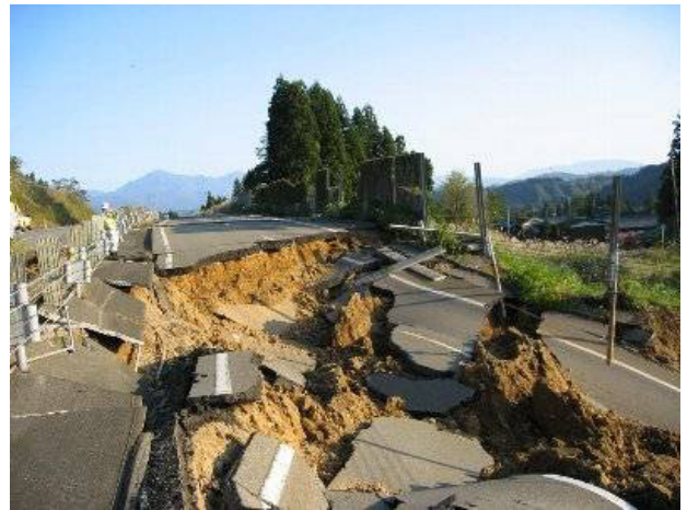
写真22 関越自動車道の盛土崩壊 2) (堀之内町)
