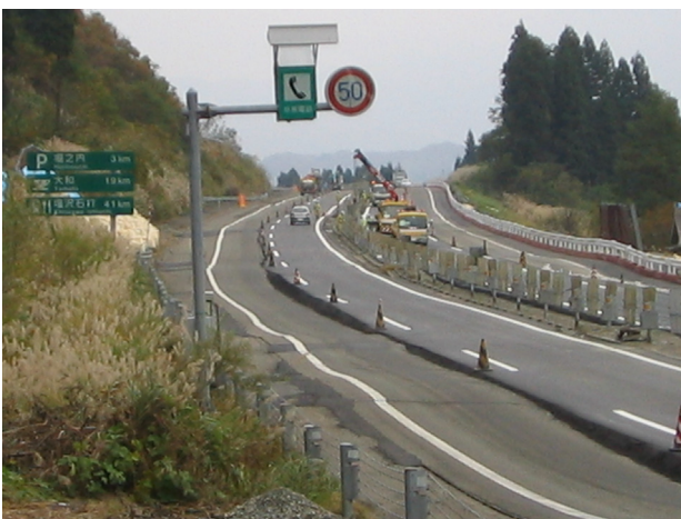
写真2 関越自動車道の盛土変形 2)
