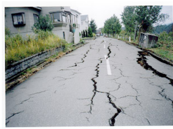
写真 38 周回道路の縦断き裂
