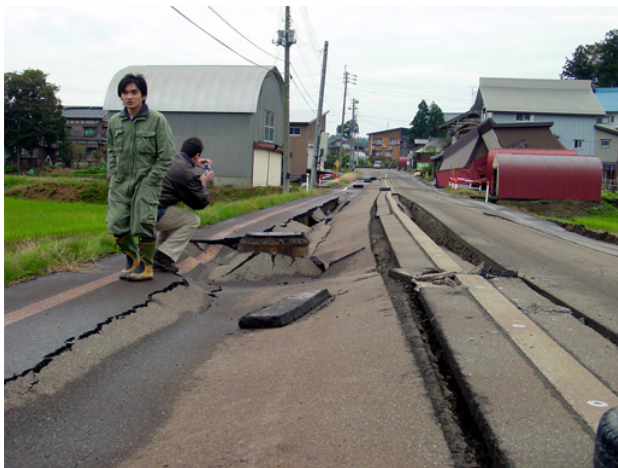
写真4 埋設管埋戻し土の沈下 3)
