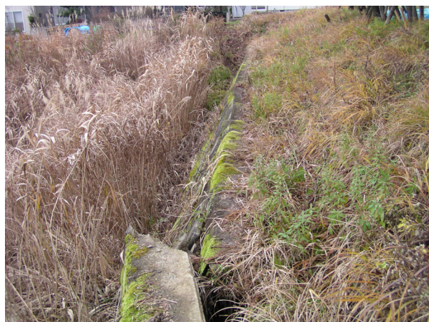
写真 40 団地周辺の重力式よう壁の変位
