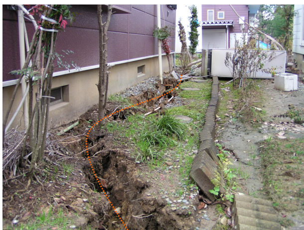
写真 37 地盤の変位による造成地内のき裂
