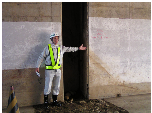
写真8 ボックス・カルバートの開口
