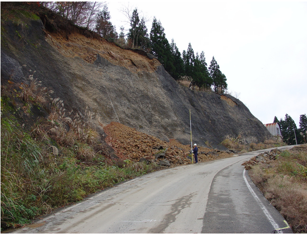
写真 26 表層崩壊による吹付けモルタルの剥落
