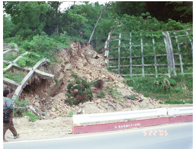
写真 28 岩盤層すべりによる切土斜面の崩壊(横渡)
