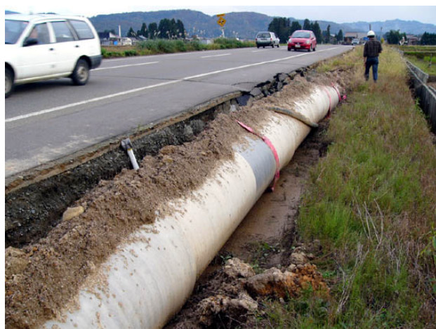
写真6 埋設管の浮き上がり 6)
