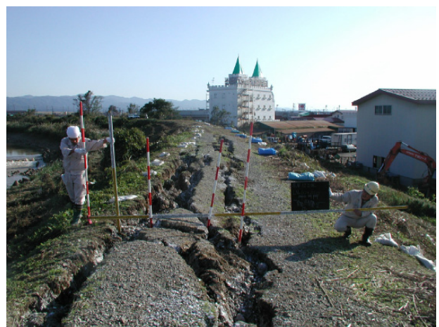
写真 12 堤防の縦断方向に発生したき裂 5) (刈谷田川)
