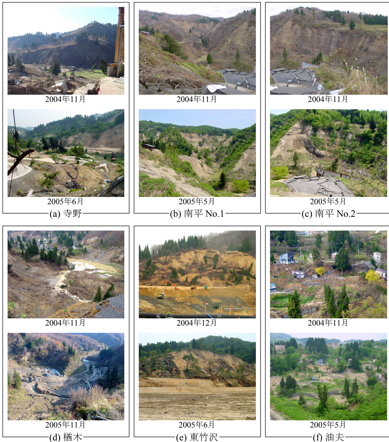
写真2 崩壊地の地震直後と融雪後の変化（その1）
