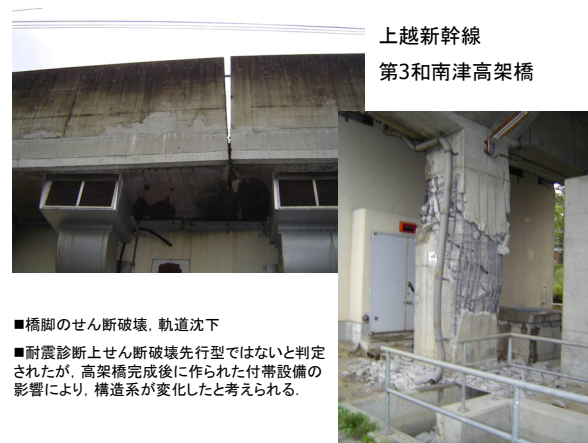
図7 上越新幹線第3和南津高架橋
