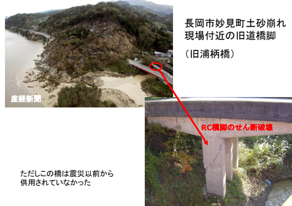
図14 長岡市妙見町旧浦柄橋
