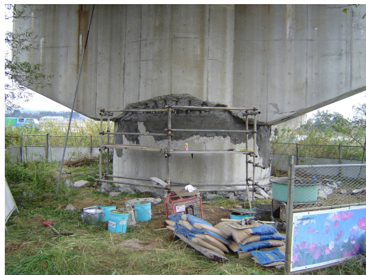
図13 国道17号線小千谷大橋
