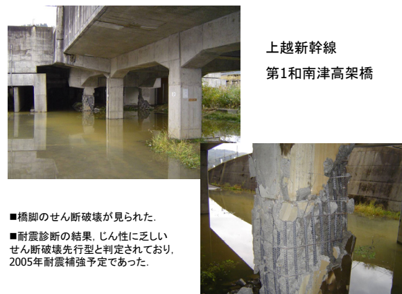
図6 上越新幹線第1和南津高架橋
