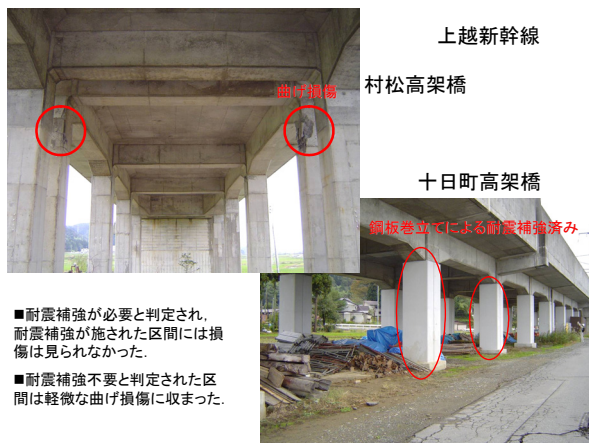
図10 上越新幹線村松高架橋と十日町高架橋
