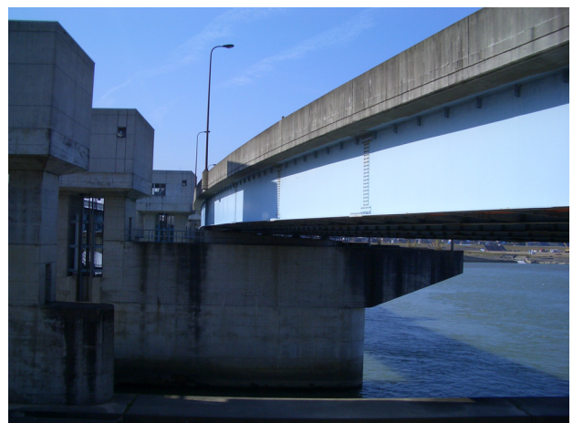
写真 11 橋台と堰の一体構造 (S2)
