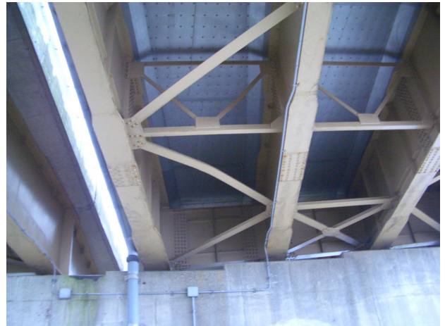
写真 27 下横構の変形 (S1)
