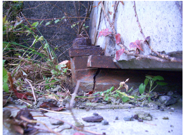
写真 21 下沓ストッパーの破断 (C5)
