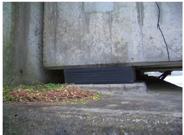
写真 22 新四日町橋の支承部
