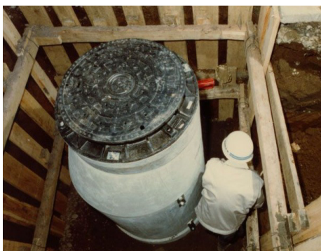
写真4 組立マンホール
