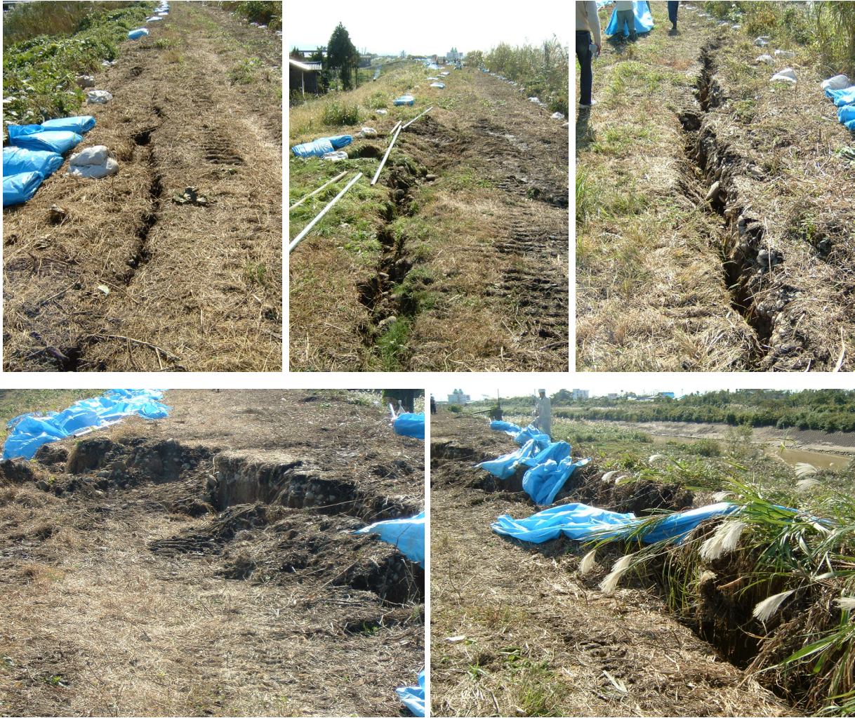
写真4 刈谷田川山吉町地先の右岸堤防
