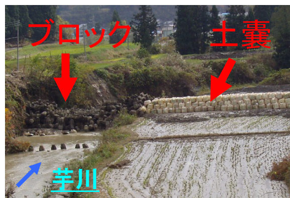
写真18 土石流対策工 (魚野川合流点より約2km上流)
