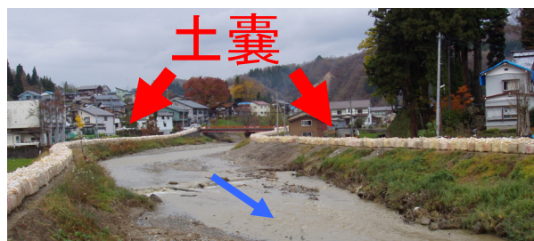
写真17 土嚢設置状況（竜光地区）
