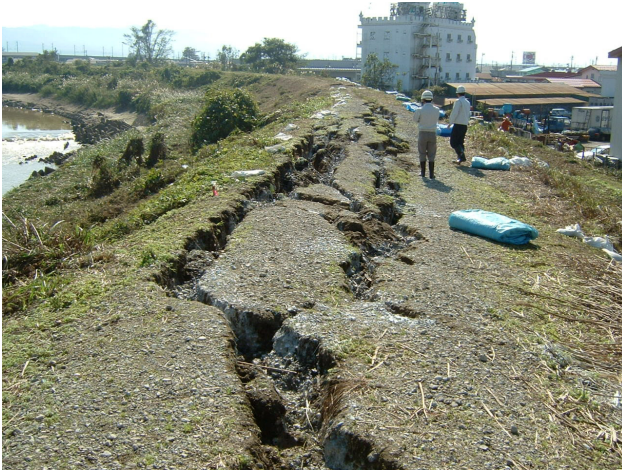
写真2 刈谷田川五百刈地先の堤防被害 【GPS】 : N 37° 31' 35" E 138° 52' 43" 2004.10.28
