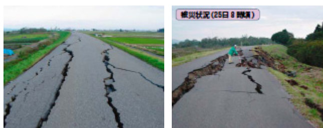
写真 1 河川堤防上の縦断方向の亀裂 1) より抜粋
