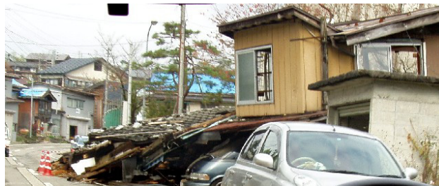
写真16 家屋被災状況（竜光地区）
