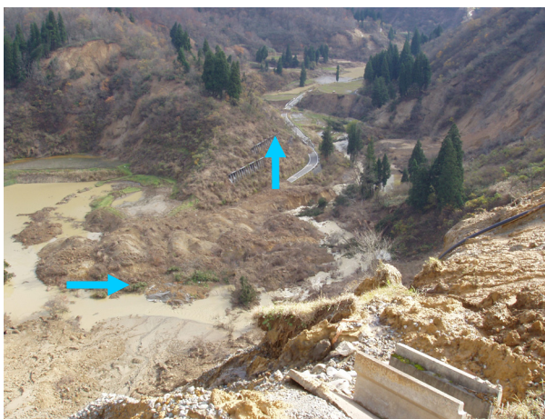
写真8 河道閉塞箇所（南平，閉塞河道）
