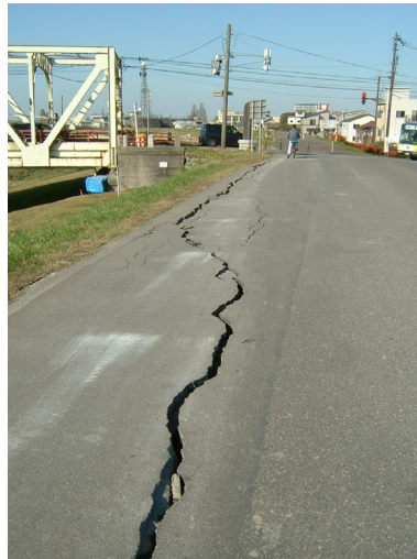
写真6 信濃川長生橋付近の堤防天端上のアスファルトの亀裂
