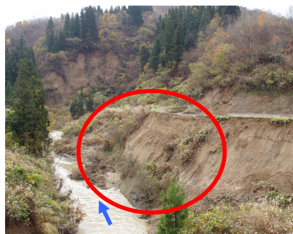
写真19 河道状況（竜光地区上流） (魚野川合流点より2.5km上流, ○:土砂崩壊)
