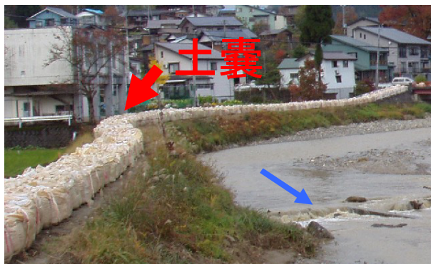
写真15 土嚢設置状況（右岸拡大）
