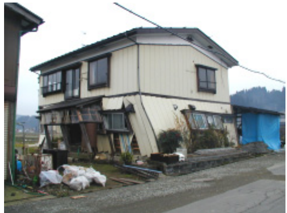
写真. 11 木造住宅の倒壊（小千谷市吉谷）
