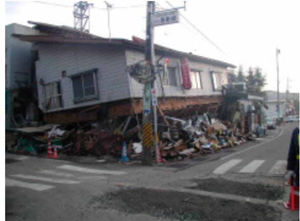
写真.15 倒壊した木造店舗（川口町川口）
