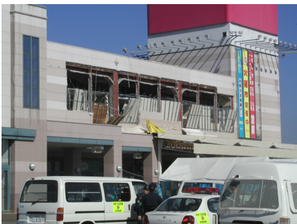
写真.28 外壁が崩落したRC造大型店舗 (小千谷市平沢新田)
