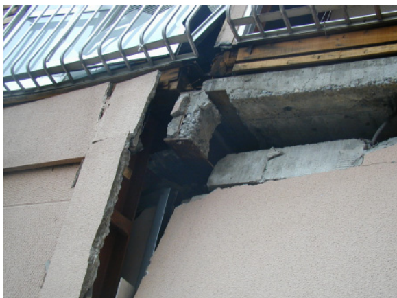
写真.27 緊結が不足した接合部 (長岡蓬平)
