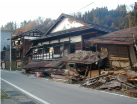
写真.14 1階部が潰れた木造老朽住宅 (川口町川口)
