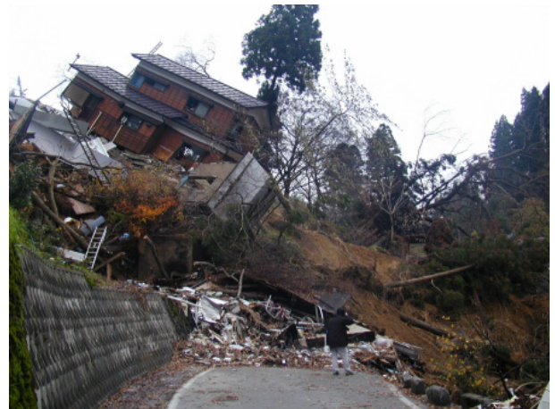
写真.2 土砂崩れにより崩落した住宅 (長岡市濁沢)
