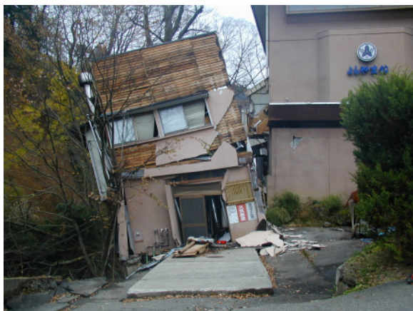
写真.26 倒壊する旅館の付属建物 (長岡蓬平)
