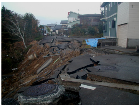
写真.5 盛り土の崩落により崩壊する外周道路（長岡市高町）
