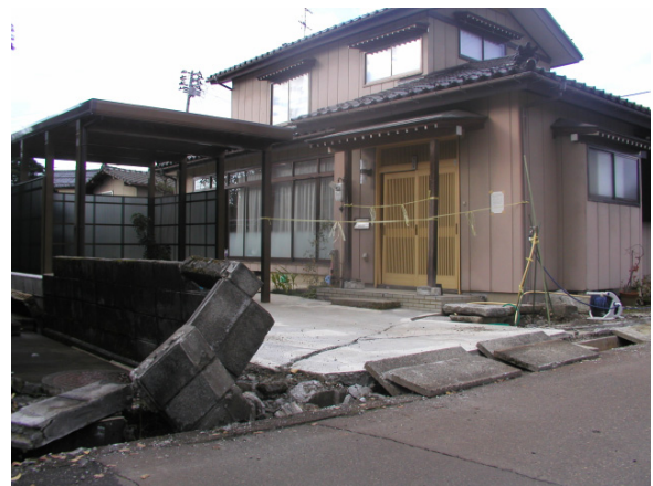
写真.3 倒壊するブロック塀と亀裂の入ったコンクリート地盤 (長岡市中沢)
