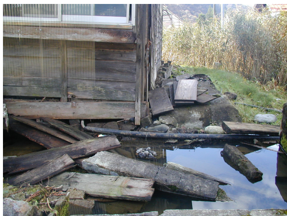
写真. 18 基礎部分が移動した住宅 (山古志小松倉)
