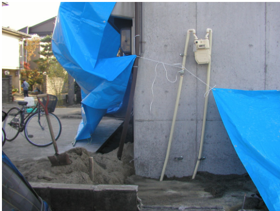
写真. 8 基礎部分の沈下と移動（小千谷市東栄）
