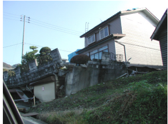
写真.1 倒壊するブロック造の駐車場 (長岡市水穴)
