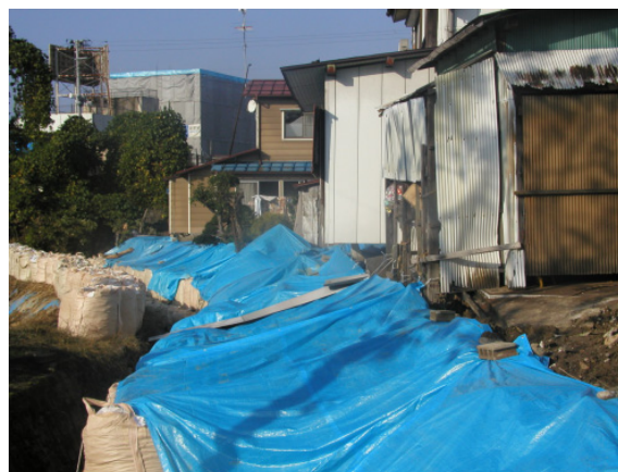
写真.7 宅地の流出（小千谷市東栄）
