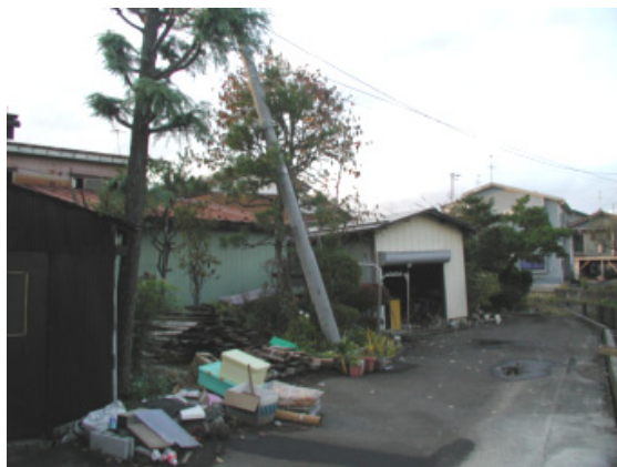
写真.4 傾斜する電柱と倒壊した木造住宅 （長岡市悠久）
