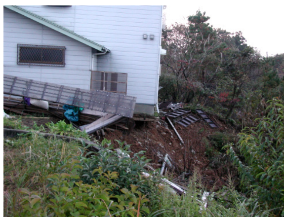
写真.6 流出した土砂により傾斜する比較的新しい住宅（長岡市高町）
