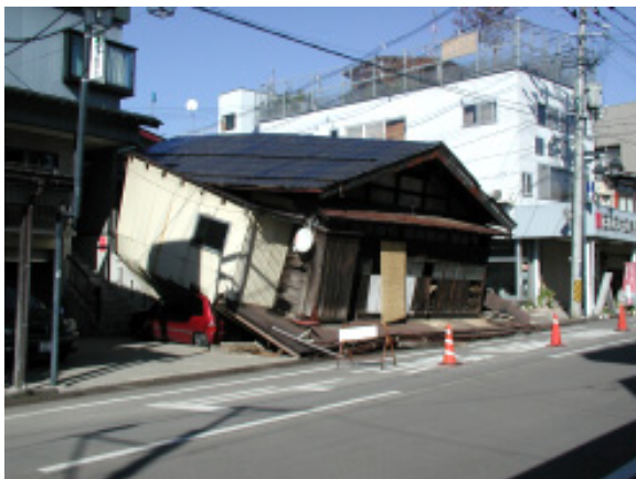
写真. 10 木造住宅の倒壊（小千谷市平成）
