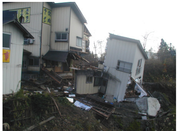
写真. 13 地盤の流出により切断された住宅（小千谷市木津）
