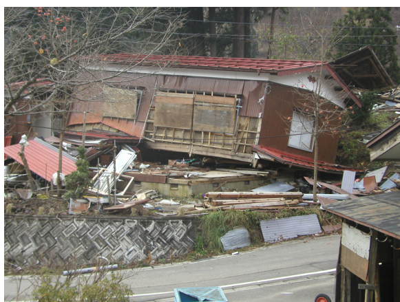
写真. 19 1階部が倒壊した木造住宅 (山古志梶金)
