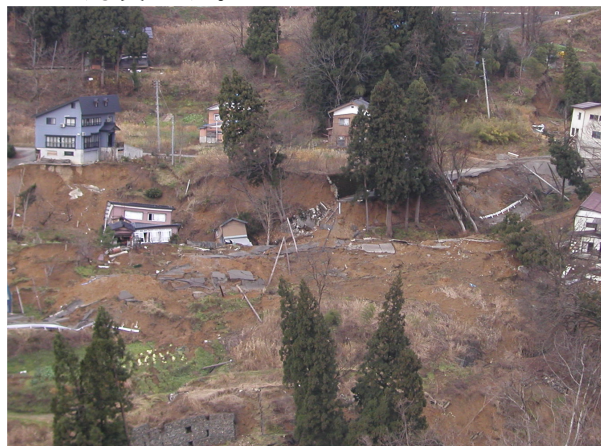
写真. 20 大規模な土砂崩れと住宅の倒壊 (山古志竹沢)
