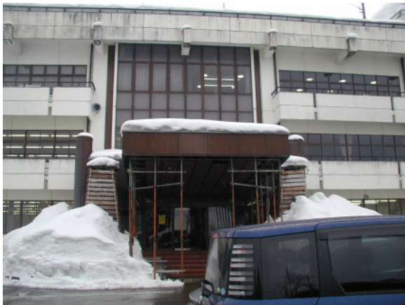
写真. 23 被災した川口町役場
