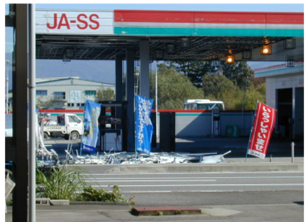
写真. 25 天井材が崩落したガソリンスタンド （小千谷片貝）
