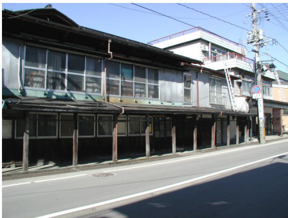
写真. 9 被害が軽微な老朽住宅と雁木（小千谷市平成）
