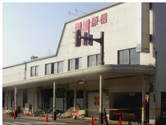
写真.29 外壁が崩落したRC造大型店舗 (小千谷市東栄)
