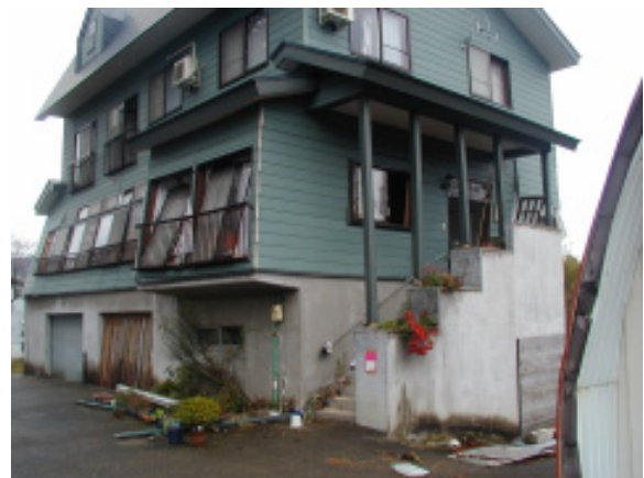
写真.16 倒壊した高床式住宅 (川口町田麦山)
