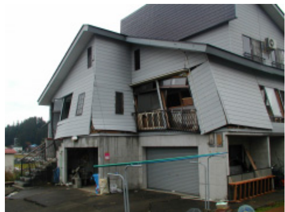
写真.17 倒壊した高床式住宅 (川口町田麦山)
