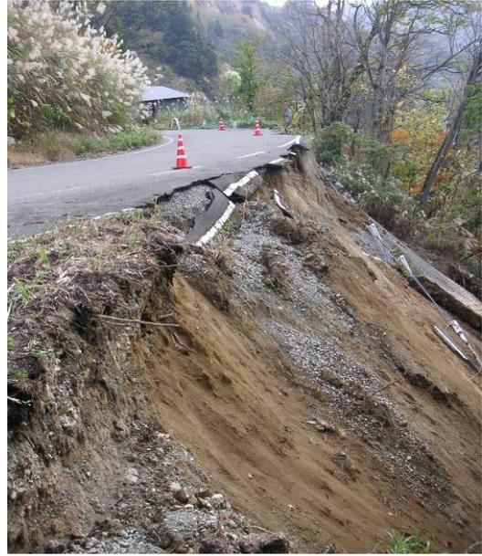
写真5 集落をつなぐ県道の部分崩落。代替道路のない地域は除雪車が入れば孤立する。
