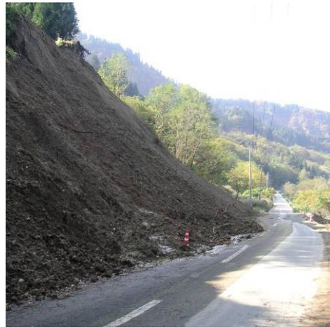
写真6 植生の落ちた斜面で雪崩の発生危険度が増大
