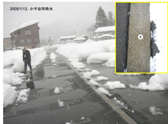
写真10 消雪施設の障害：散水が割れ目に流れ込み消雪が不十分で1車線しか確保されていない(2005/1/15, 小千谷市時水)。
