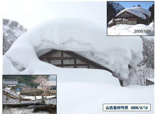
写真 12 屋根雪除雪がなされず倒壊した家
