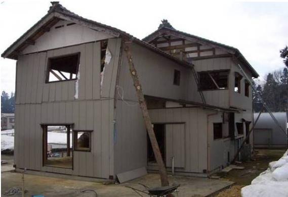
写真7 農業資機材・家財道具を保管するために応急の補強で冬を越した住宅
