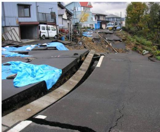
写真4 陥没道路と壊滅的ダメージを受けた消雪パイプ。仮にポンプ施設、散水部が健全でも、道路に亀裂
