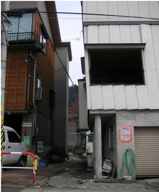
写真3 地震によって傾いた家屋。平年積雪が2mの地域。積雪荷重によって倒壊する危険性が高い。万一倒れれば隣家へ寄りかかり二次災害を引き起こす。
